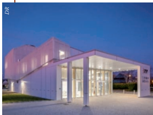
Bâtiment de la SCIC
